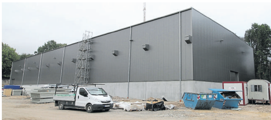
Der Neubau von Gilne in Uffeln hat sehr beachtliche Dimensionen: 100 mal 32 Meter misst die Halle. Auf dem Grundstück ist reichlich Platz, zwei weitere Produktionshallen gleichen Ausmaßes wären machbar.
