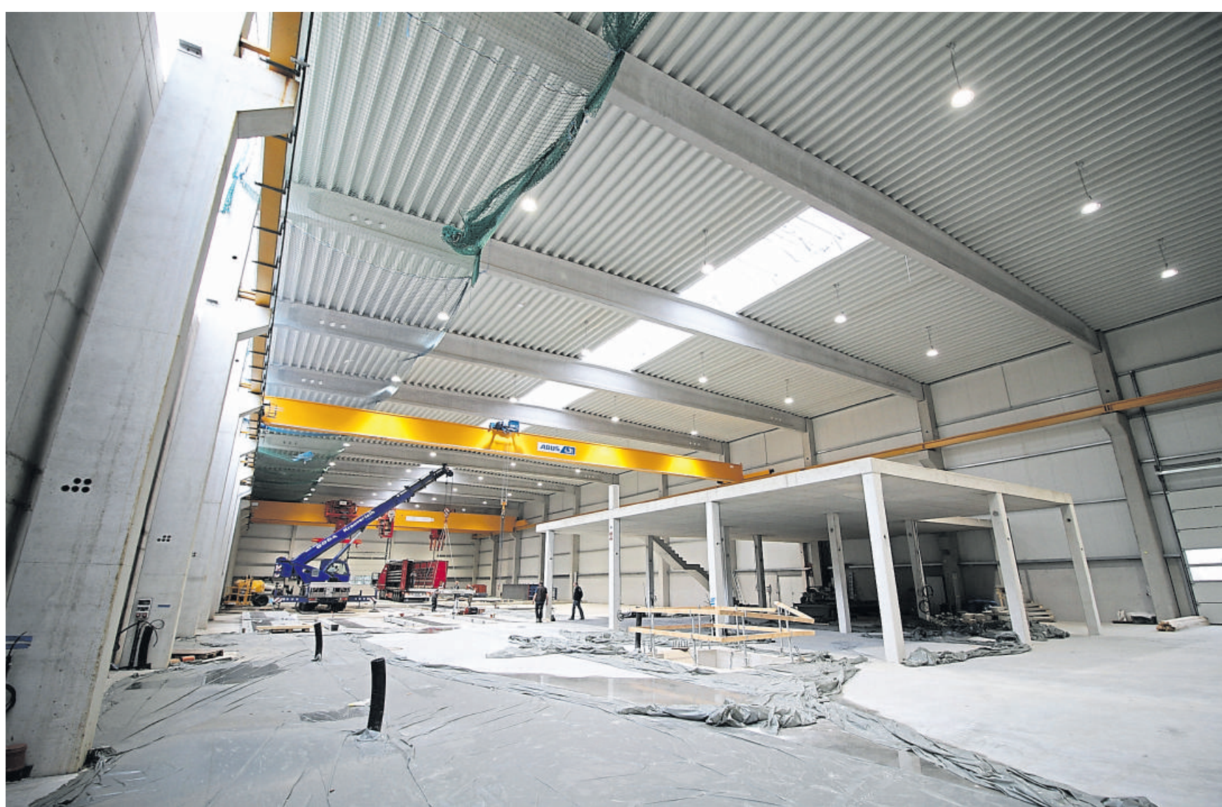
Auch im Inneren der neuen Produktion ist reichlich Platz: Der Autokran und der Sattelzug, die hier Maschinenteile anliefern, wirken fast wie Spielzeugautos.
